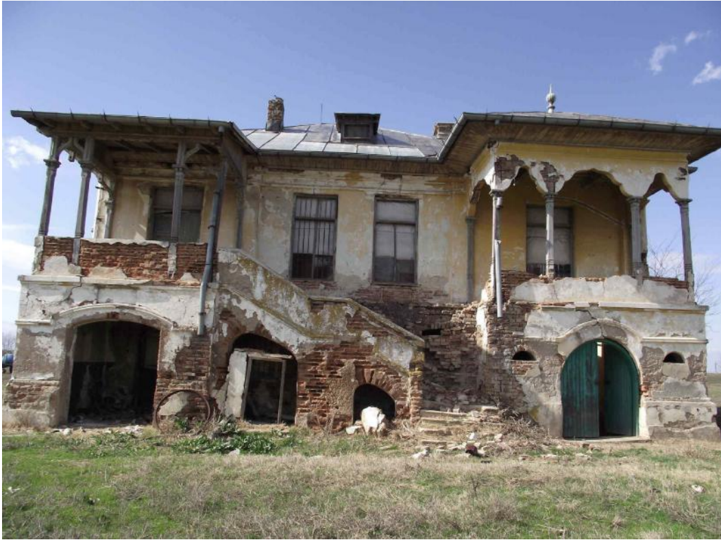
Fig. 1 Conacul Sihleanu, aflat pe malul stâng al râului Buz u, vedere fa ad
